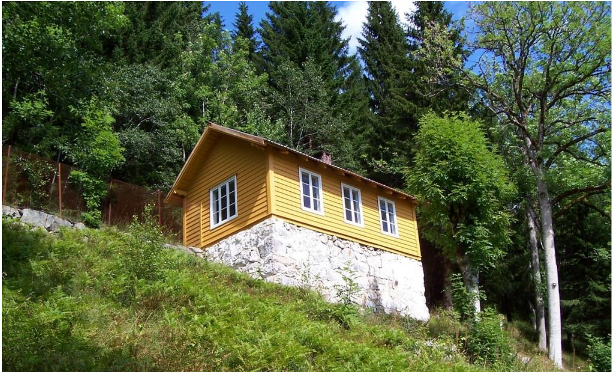
Figur 5-27. Skulehuset i Eitorn, ferdig restaurert. Foto: Ola A. Vestrheim.
