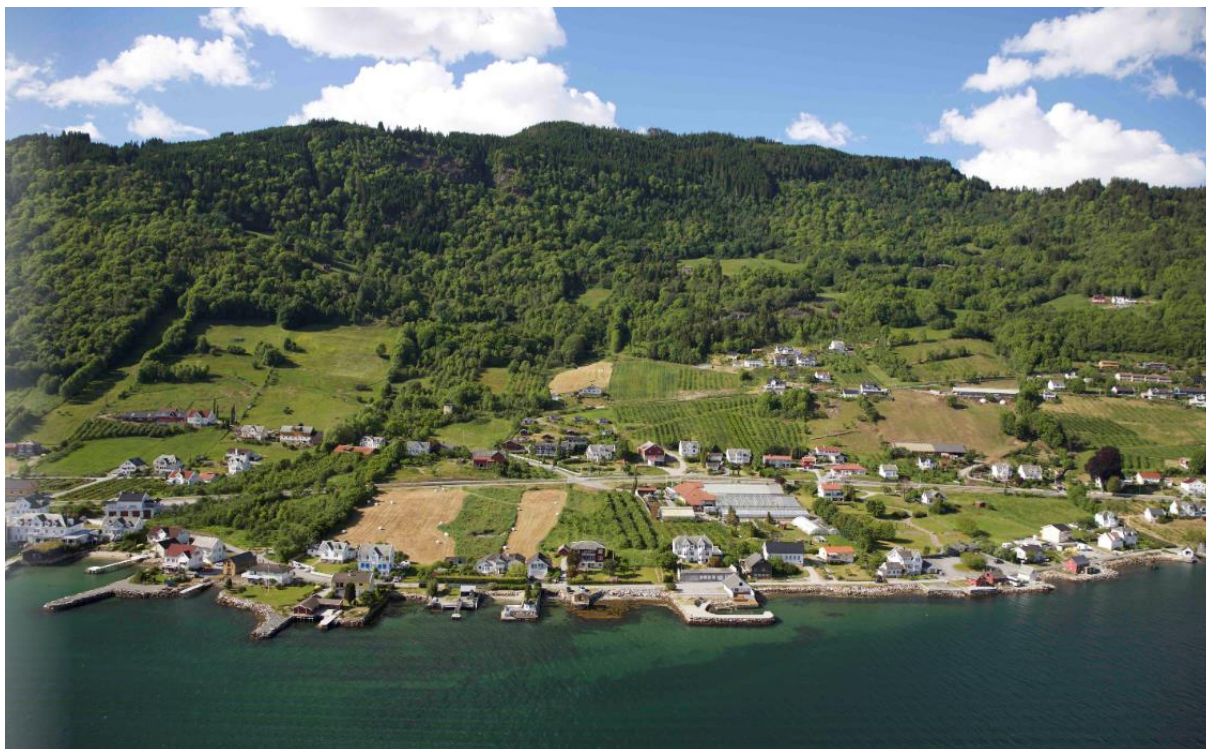
Figur 5-17. Husabø med tunområde og kulturlandskap. Baldershagen til høyre for gartneriet. I framkant Strandavegen med fleire prioriterte kulturminne (Leikanger Fjord Hotel, tønnefabrikken v/Hårfagreparken, Vangsnes fiskemat og bedehuset). Foto: Håvard Nesbø.
