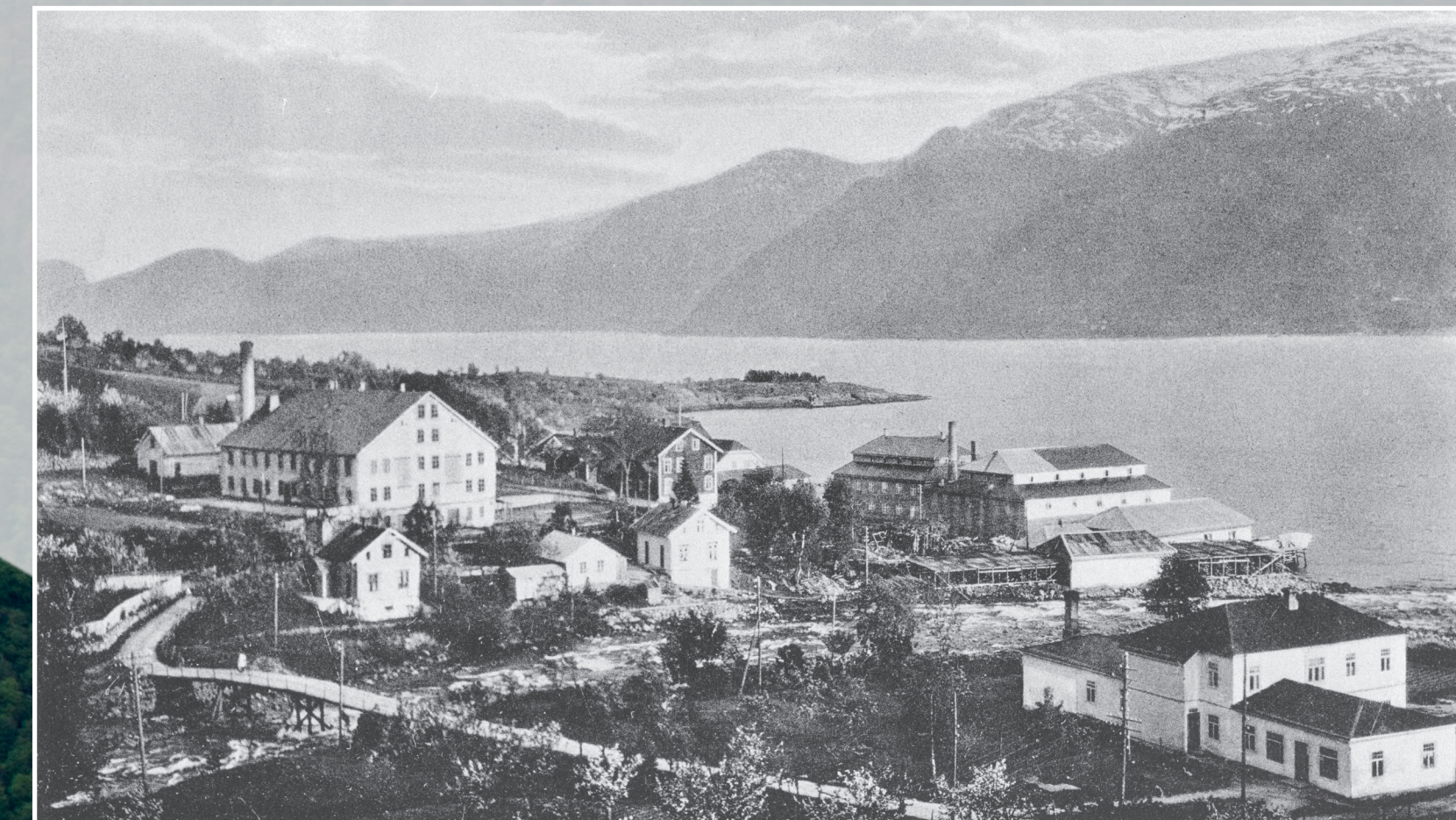
Hermansverk i tidlegare tider. «Saften» i midten av biletet og «Silden» lengst ned mot fjorden, på austsida av Henjaelvi. Foto: SFFF-1993357.101493
